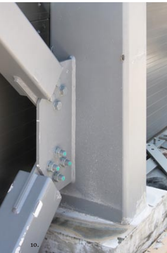
Kuva 10: Aiemmat puiset kattokaaret olivat kiinni betonisiivissä. Osa siivistä on vahvistettu manttelimalla kahdelta sivulta kantamaan niiden päälle asennetut uudet 6,5 metrin teräksiset liittopilarit ja uudet 57 metrin kattoristikot toisesta päästään. Kuvan vinositeet ovat pysyvää rakennetta.
