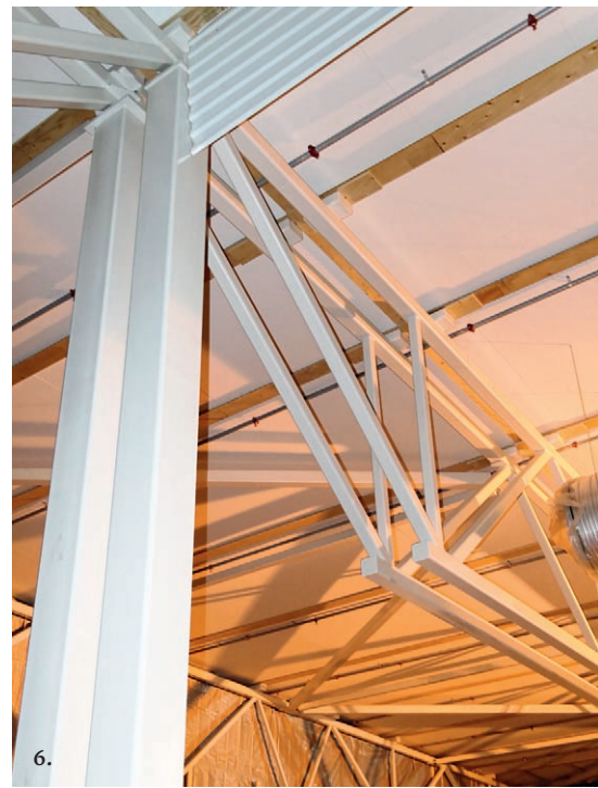
Kuva 6: Rakennusmassan keskellä on yksi liikunta- sauma.
