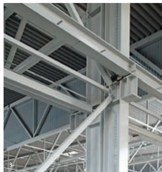
Kuvat 1–3: Näkymiä Beam-Netin valmistamasta ja Temacon Finlandin Ferrometalin kiinnittimiä hyödyntäen asentamasta rungosta.
